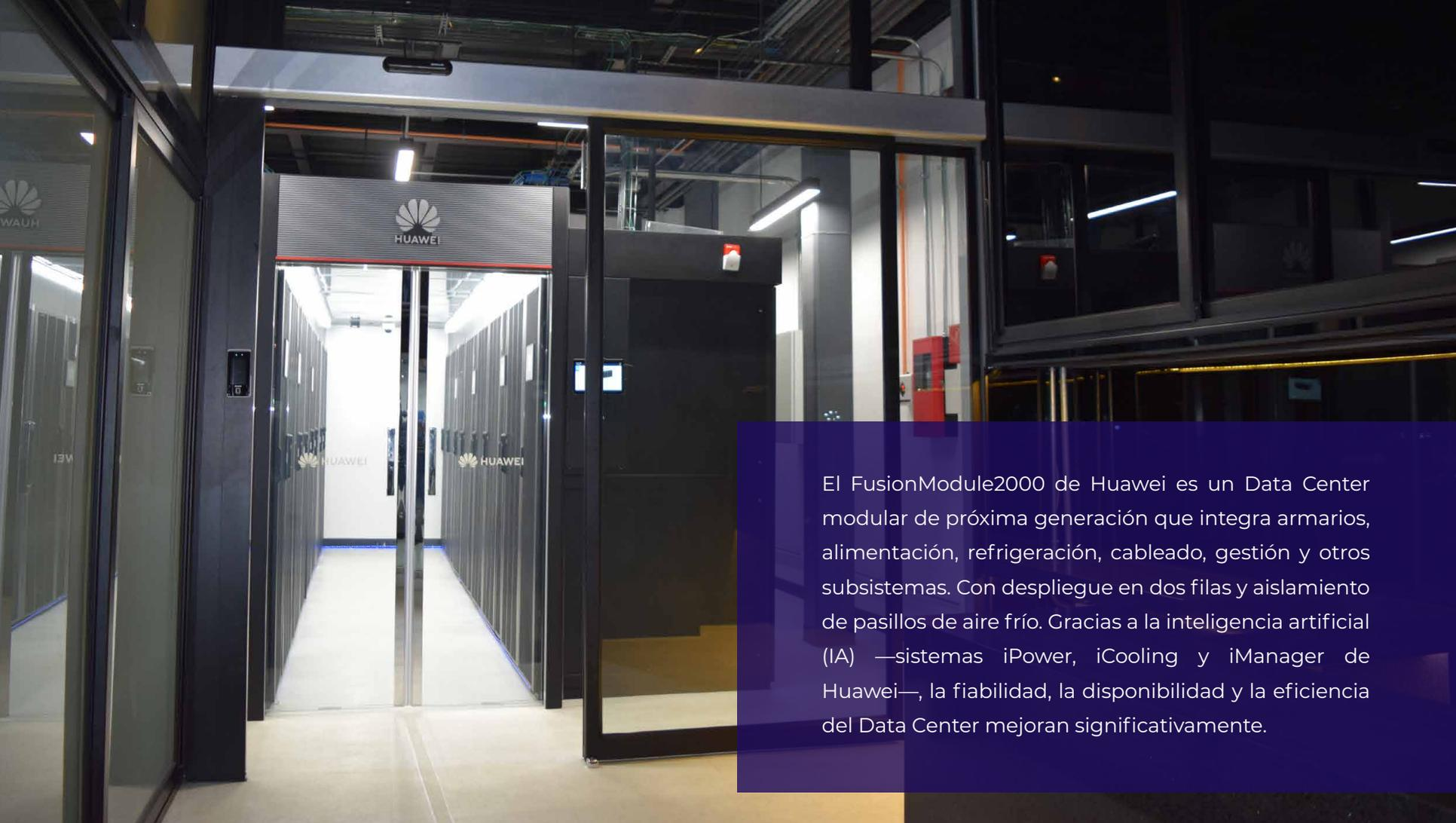
El FusionModule2000 de Huawei es un Data Center modular de próxima generación que integra armarios, alimentación, refrigeración, cableado, gestión y otros subsistemas. Con despliegue en dos filas y aislamiento de pasillos de aire frío. Gracias a la inteligencia artificial (IA) —sistemas iPower, iCooling y iManager de Huawei—, la fiabilidad, la disponibilidad y la eficiencia del Data Center mejoran significativamente.
